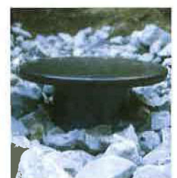
杭頭キャップのセット Setting the pile head cap
