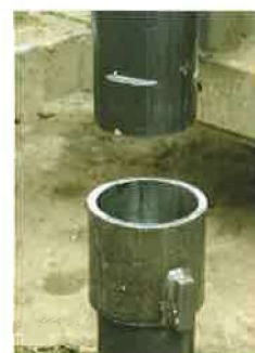
ソケット継手 Socket joint
