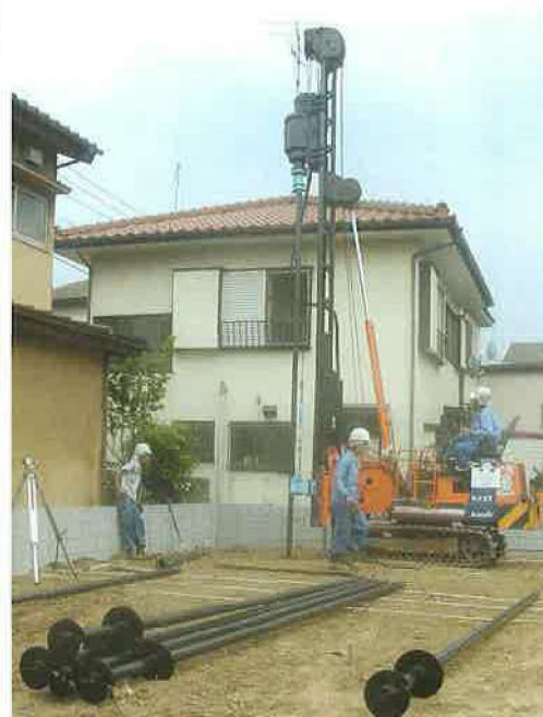
ホームパイル キャリー施工状況 Construction status of the Home Pile Carry
