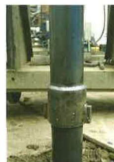
ソケット継手・溶接完了 Welding completed, socket joint
