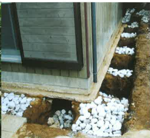
ホームパイル キャリー 施工後の基礎補強
