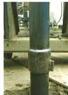
ソケット継手・溶接完了
