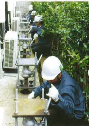
沈下修正のジャッキアップ
