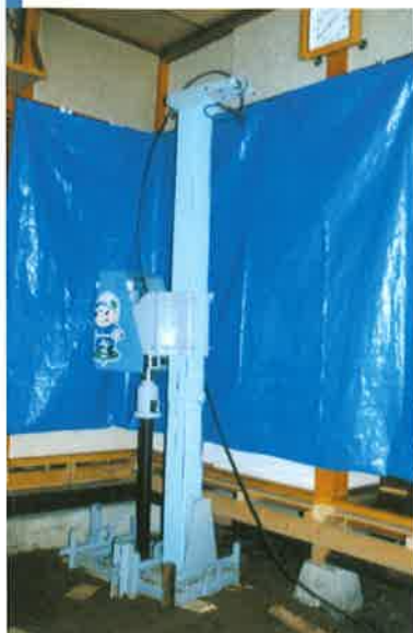
居住しながら床下沈下補強
